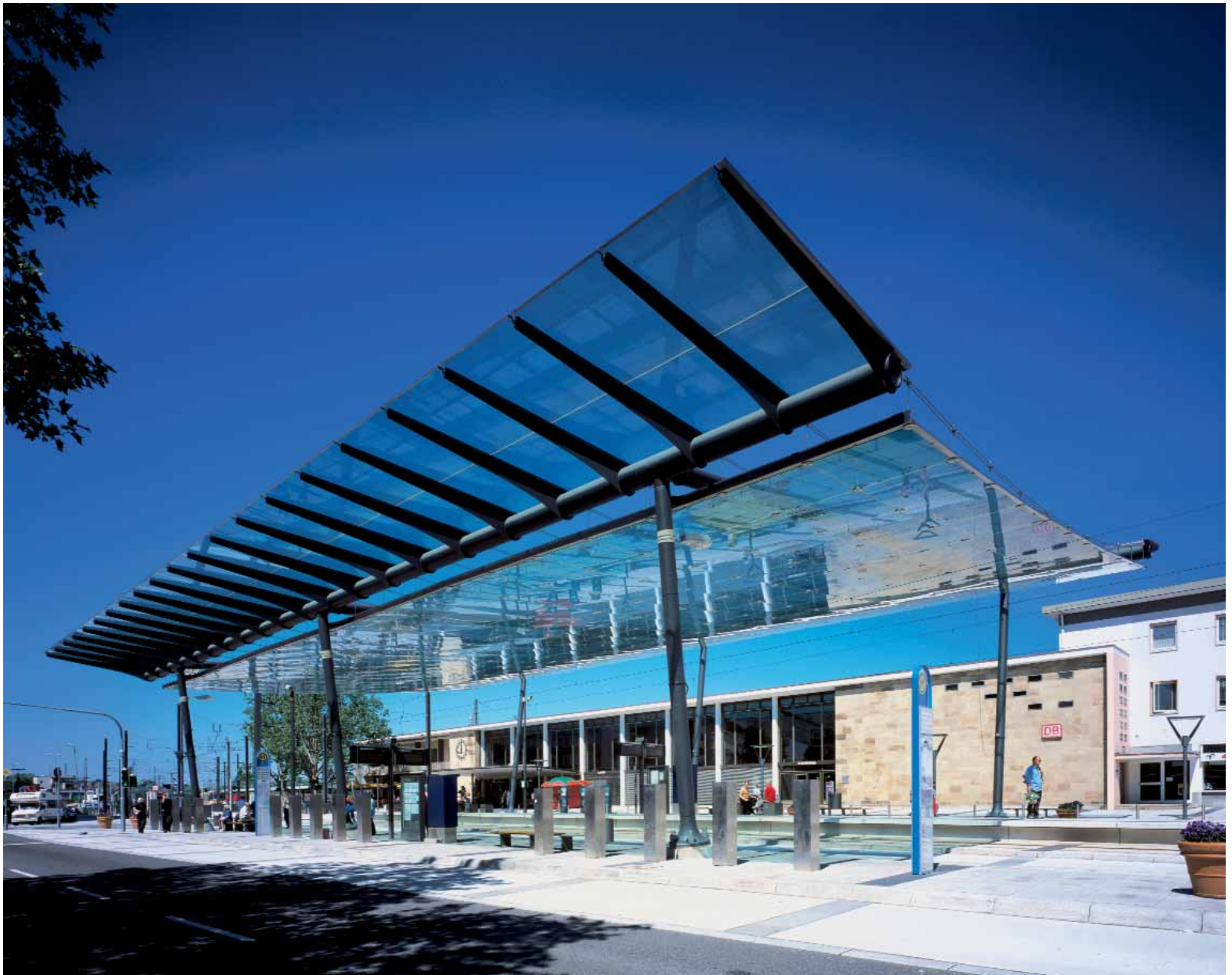
Glasdach über dem Bahnhofsvorplatz
