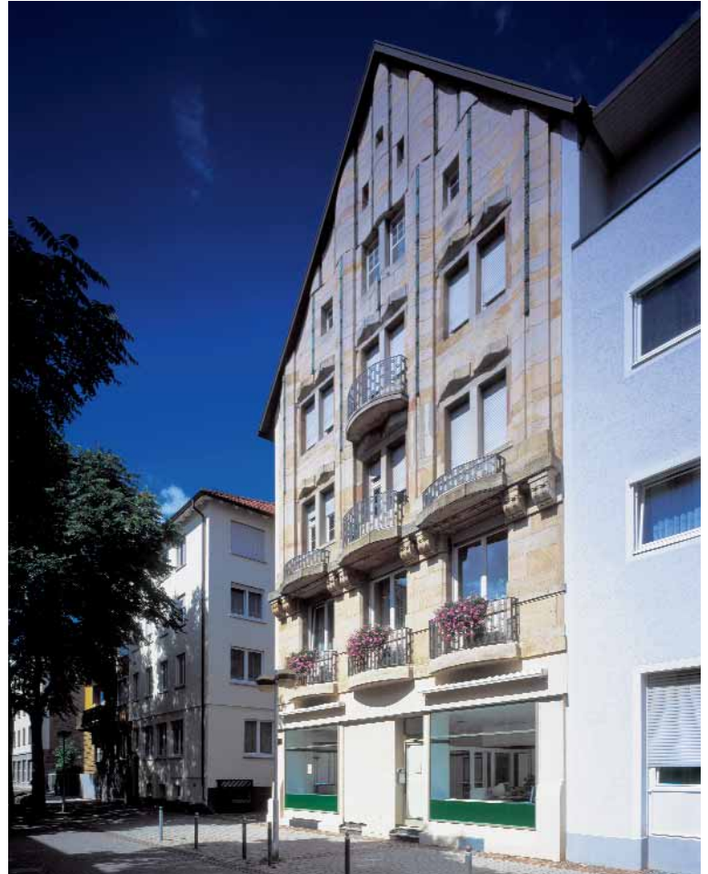
Wohn- und Geschäftshaus, Rosskampffstraße
