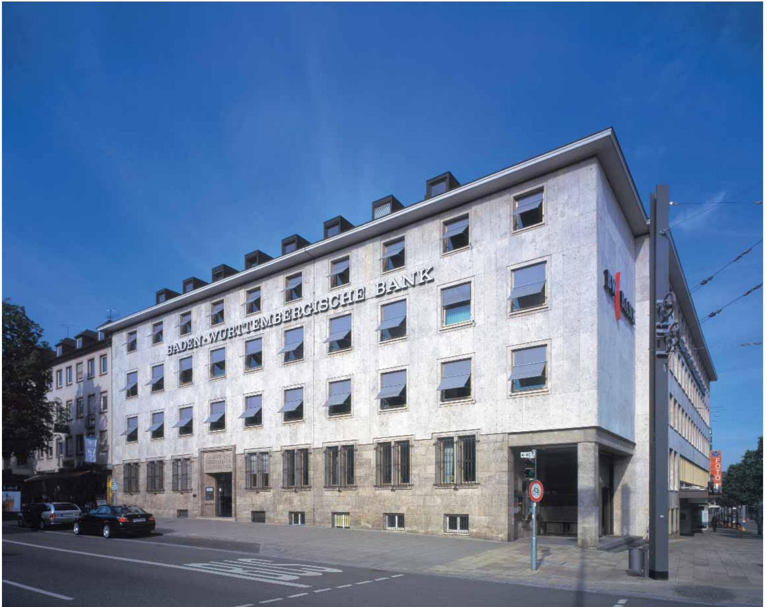
Ehemalige Handels- und Gewerbebank, Heute BW-Bank
