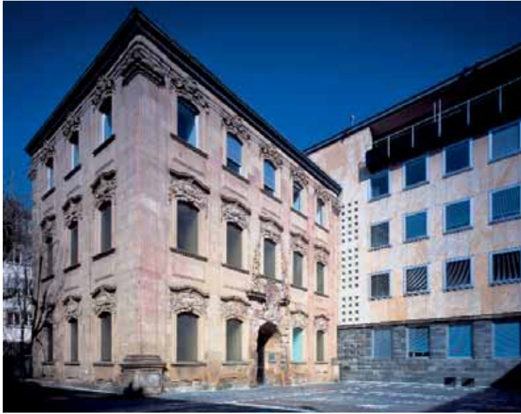
Archivbau am Rathaus
