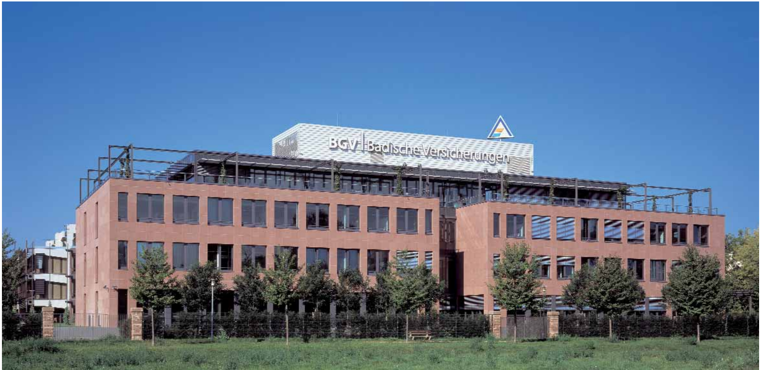
„Fächergebäude“ Badischer Gemeindeversicherungsverband
