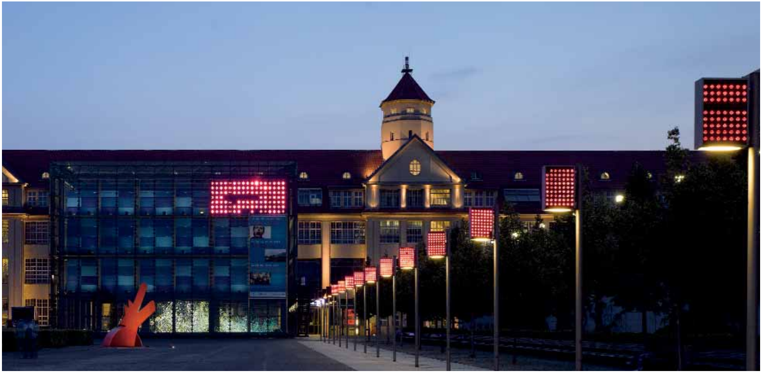
ZKM (Hallenbau A)
