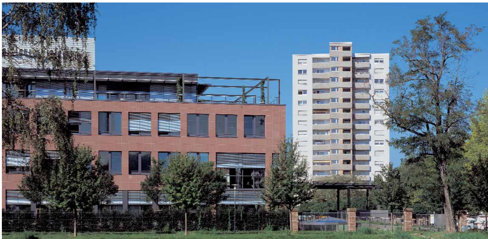
„Fächergebäude“ Badischer Gemeindeversicherungsverband
