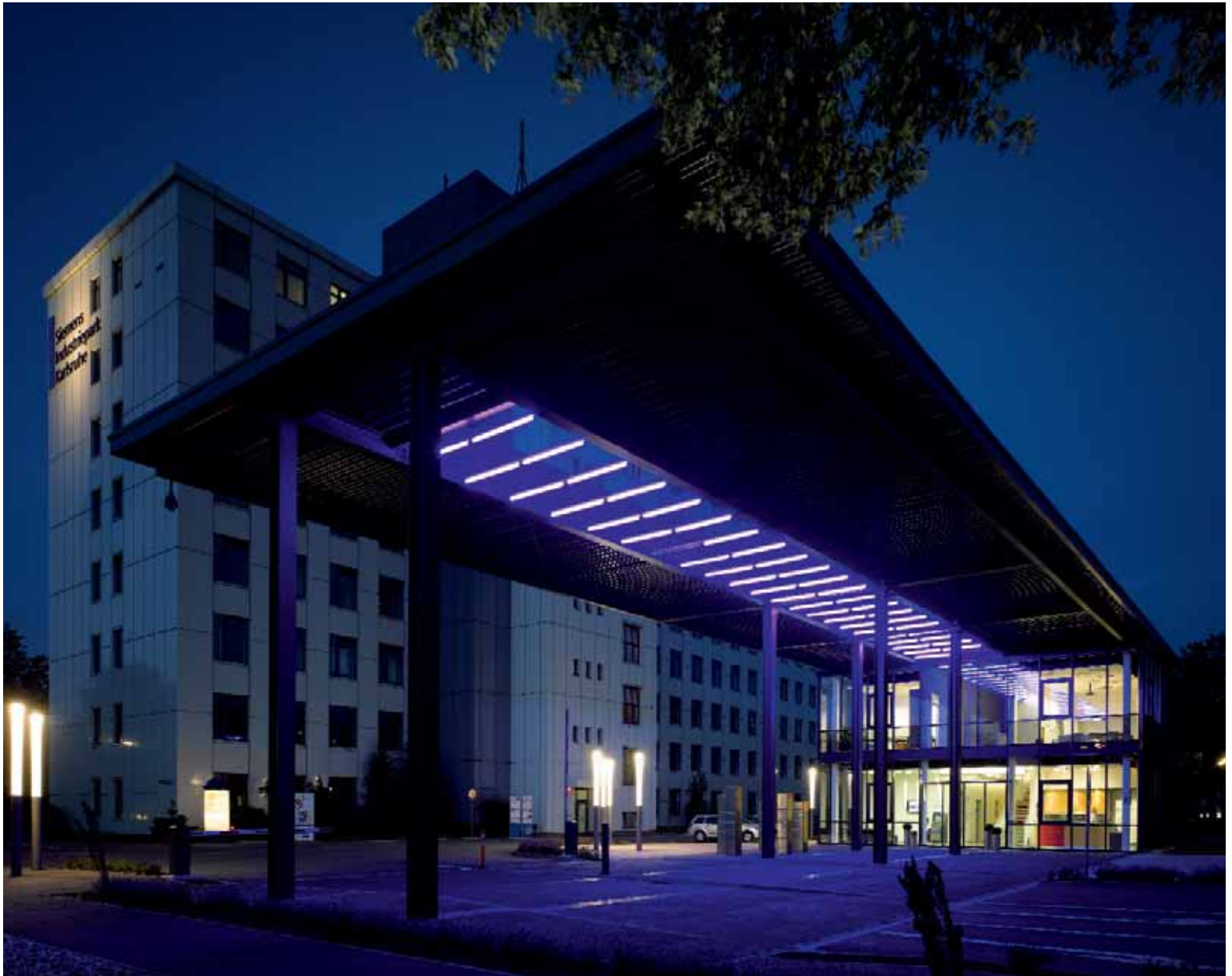
Siemens Industriepark Karlsruhe, Portal
