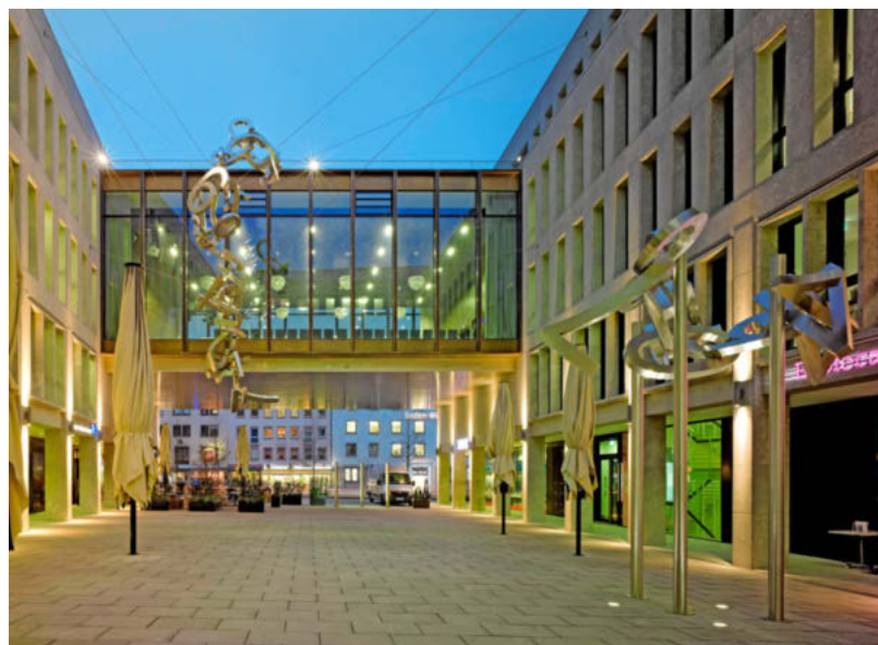
An der Allee zeugt der Neubau der Volksbank Heilbronn von der Aufwertung der Heilbronner „Hauptstraße“, deren östliche Seite durch die dortigen Lokale belebt wurde.
