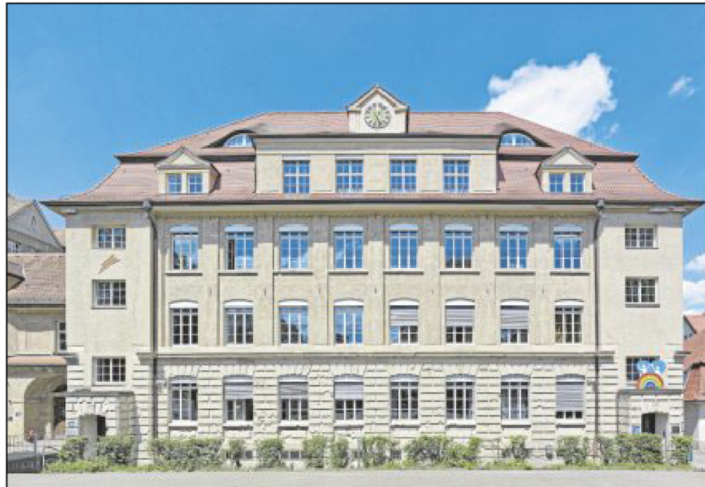
Die Pestalozzischule gehört zu den Gebäuden, die von dem für Backnang bedeutenden Architekten Christian Hämmerle Anfang des letzten Jahrhunderts entworfen wurden. Foto: Bernhard J. Lattner
