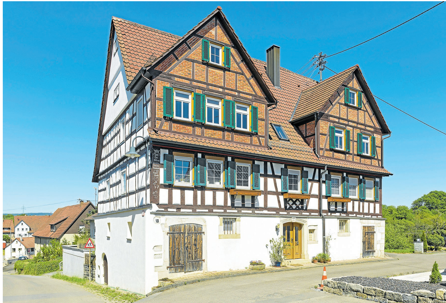
Auch bei diesem Wohnstallhaus von 1789 in Mittelschöntal handelt es sich um ein Denkmal. Das Gebäude mit zwei Zwerchhäusern wurde laut der geschnitzten Inschrift vom Zimmermann David Krauter für Andreas und Barbara Baumann errichtet.
